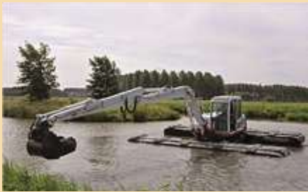
Удаление загрязненного грунта производится специальной техникой.
