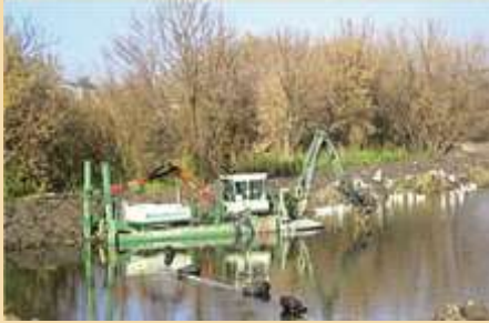
Удаление загрязненного грунта производится специальной техникой.
