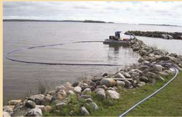
При очистке водоема от химикатов чаще всего применяют подвижные мини земснаряды, оборудованные фильтрационными установками.
