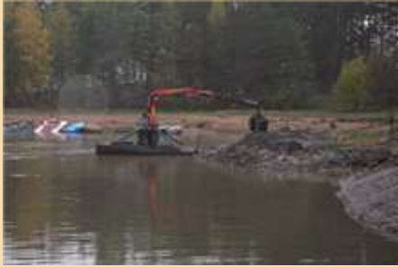
Удаление загрязненного грунта производится специальной техникой.
