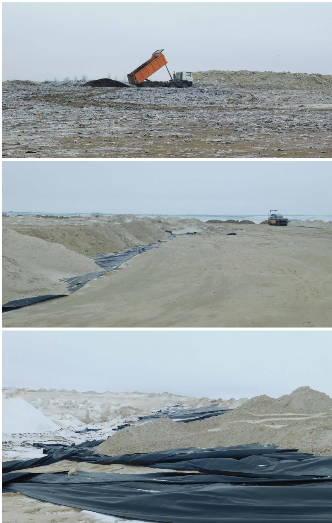
Рис. 13.5–13.8. Ход ликвидационных работ на территории свалки вблизи городского округа – город Камышин
