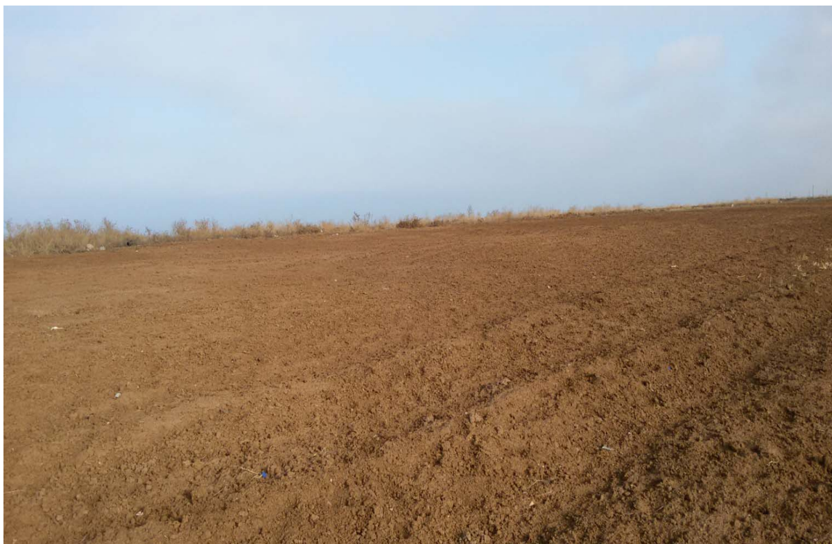
Рис. 13.2. Территория свалки вблизи х. Рахинка в период проведения работ по рекультивации
