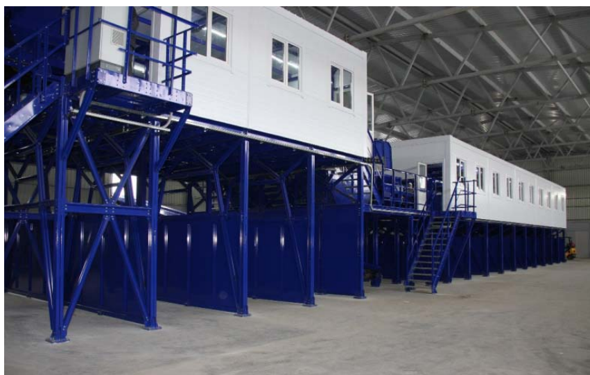
Рис. 13.9–13.10. Объект обработки ТКО в г. Волжском
